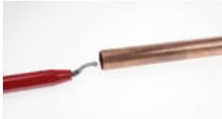
Chanfrar as bordas inferiores e exteriores (tubo de metal); caso seja necessário efetuar dobras no tubo, realizar essa operação antes da ligação.
